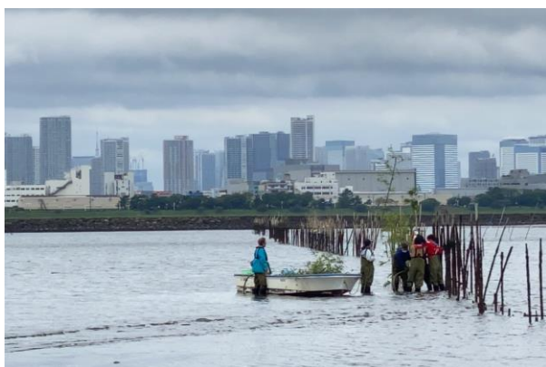
竹ひび設置作業の様子
